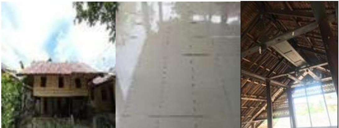
Gambar 3. Kondisi Penutup Atap Seng pada Salah Satu Unit Rumoh Aceh, Pelat Lantai yang Telah Diganti dengan Keramik, Kondisi Kolom dan Balok Kayu yang Tetap Dipertahankan
